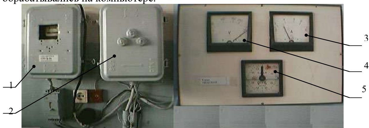
1 – счетчик электроэнергии; 2 – электрический щит; 3 – амперметр; 4 – вольтметр; 5 - фазометр
